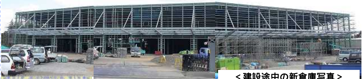
< 建設途中の新倉庫写真 >
